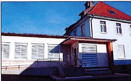
Côté école, toutes les mises aux normes ont été faites.
