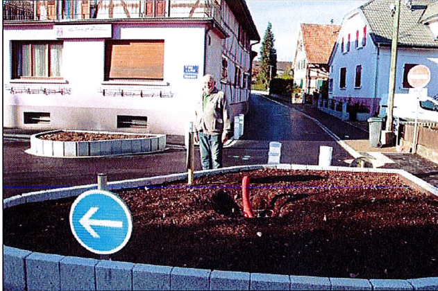
Un des gros chantiers du mandat : la rue du Rhin.
